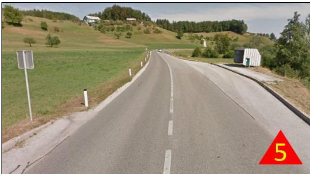
IZPOSTAVLJENA TOČKA ŠT. 5 Postajališče v Hrenovi. Previdno prečkanje cestišča.
