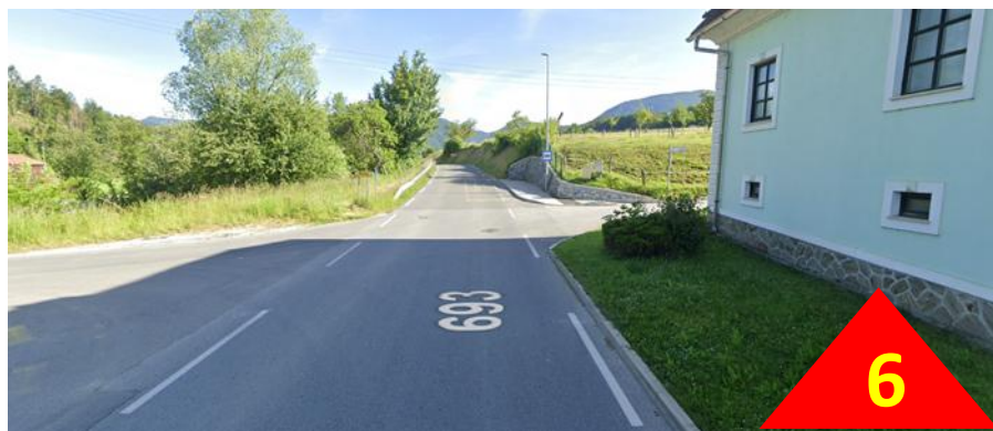
IZPOSTAVLJENA TOČKA ŠT. 6 Nepregledni del lokalne ceste pri postajališču v Razdelju.
