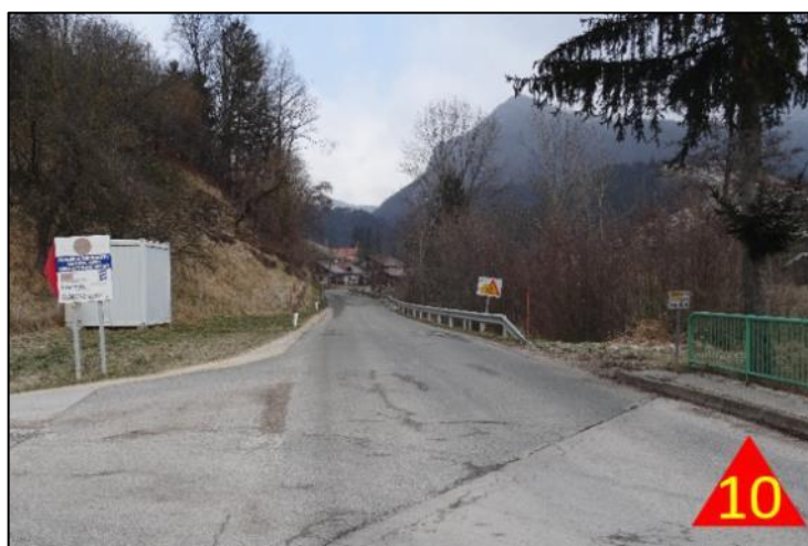
IZPOSTAVLJENA TOČKA ŠT. 10
