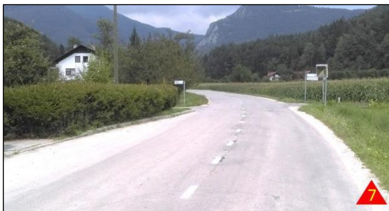
IZPOSTAVLJENA TOČKA ŠT. 7
