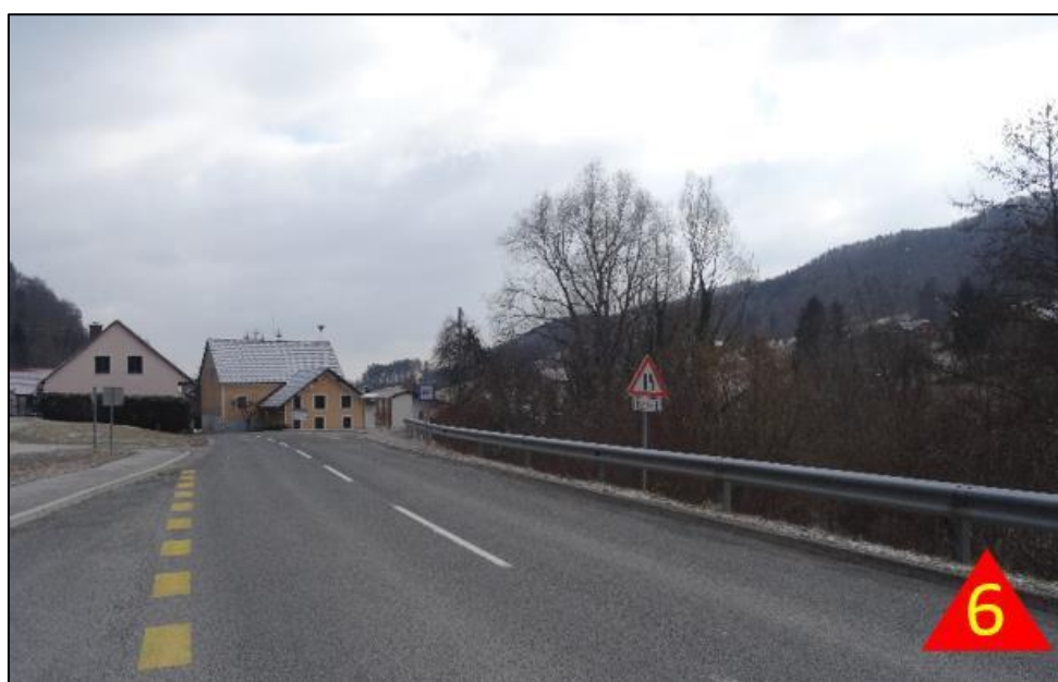
IZPOSTAVLJENA TOČKA ŠT. 6 Postajališče v Lembergu. Previdno prečkanje cestišča.
