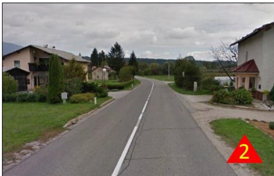
IZPOSTAVLJENA TOČKA ŠT. 2 Del lokalne ceste brez pločnika.
