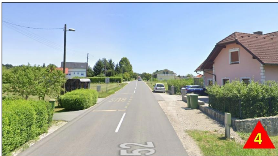
IZPOSTAVLJENA TOČKA ŠT. 4 Celotna cesta je nevarna. Ni urejenih pločnikov.
