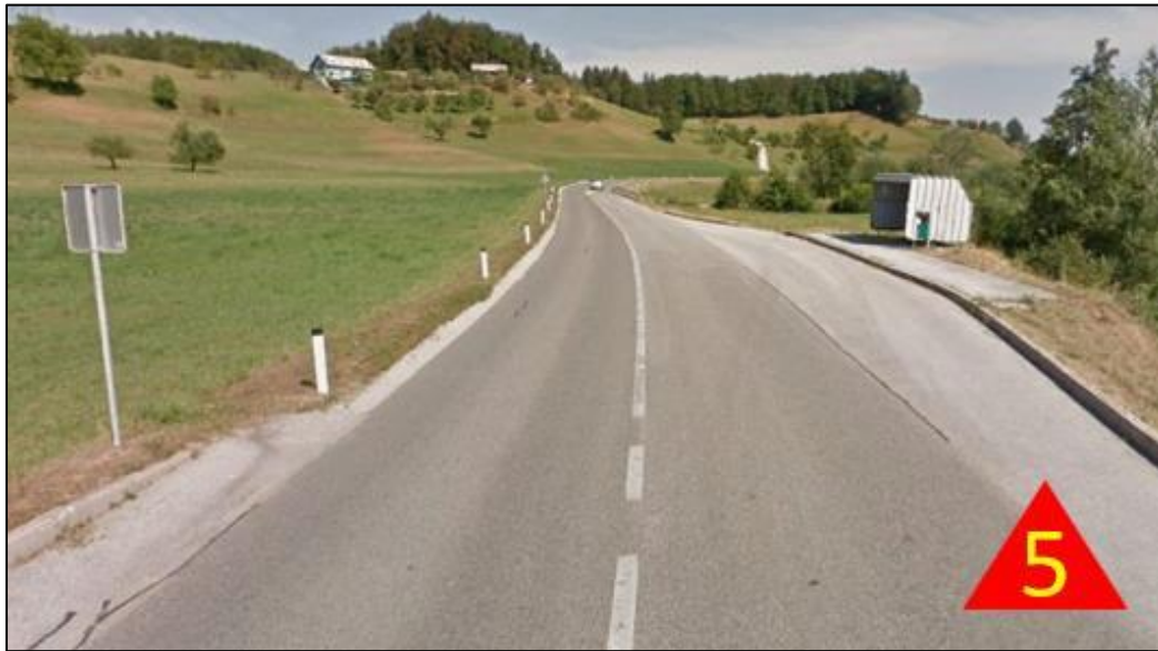
NEVAREN ODSEK ŠT. 5 Postajališče v Hrenovi. Previdno prečkanje cestišča.
