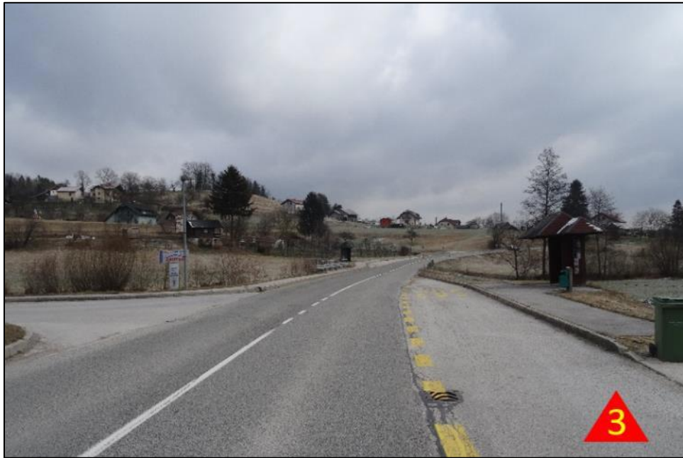
NEVAREN ODSEK ŠT. 3 Neznačen prehod za pešce na nepreglednem delu cestišča.
