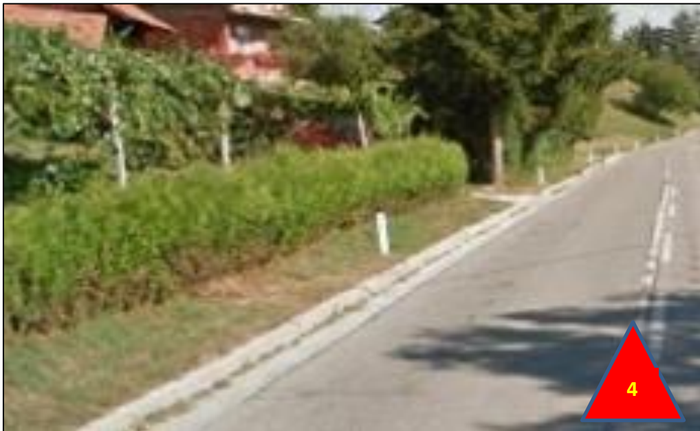
NEVAREN ODSEK ŠT. 4 Nevarno cestišče v Hrenovi.
