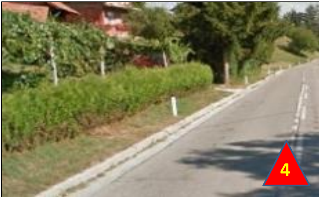
NEVAREN ODSEK ŠT. 4 Nevarno cestišče v Hrenovi.
