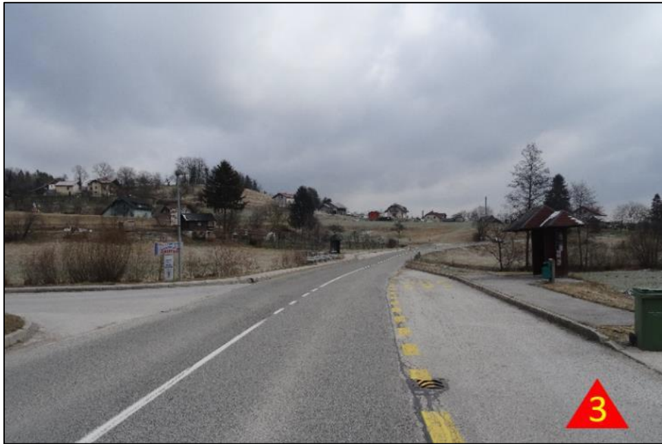
NEVAREN ODSEK ŠT. 3 Neoznačen prehod za pešce na nepreglednem delu cestišča.
